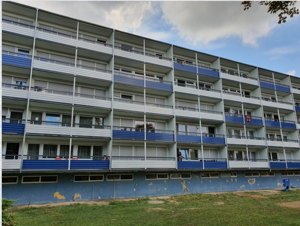
Geländer ohne Dübelbefestigung am Boden
