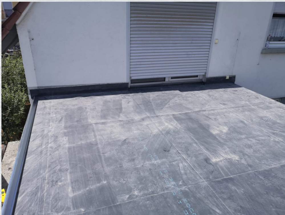
Nach dem Gefällestyropor wird die Abdichtung an einem Stück montiert.
