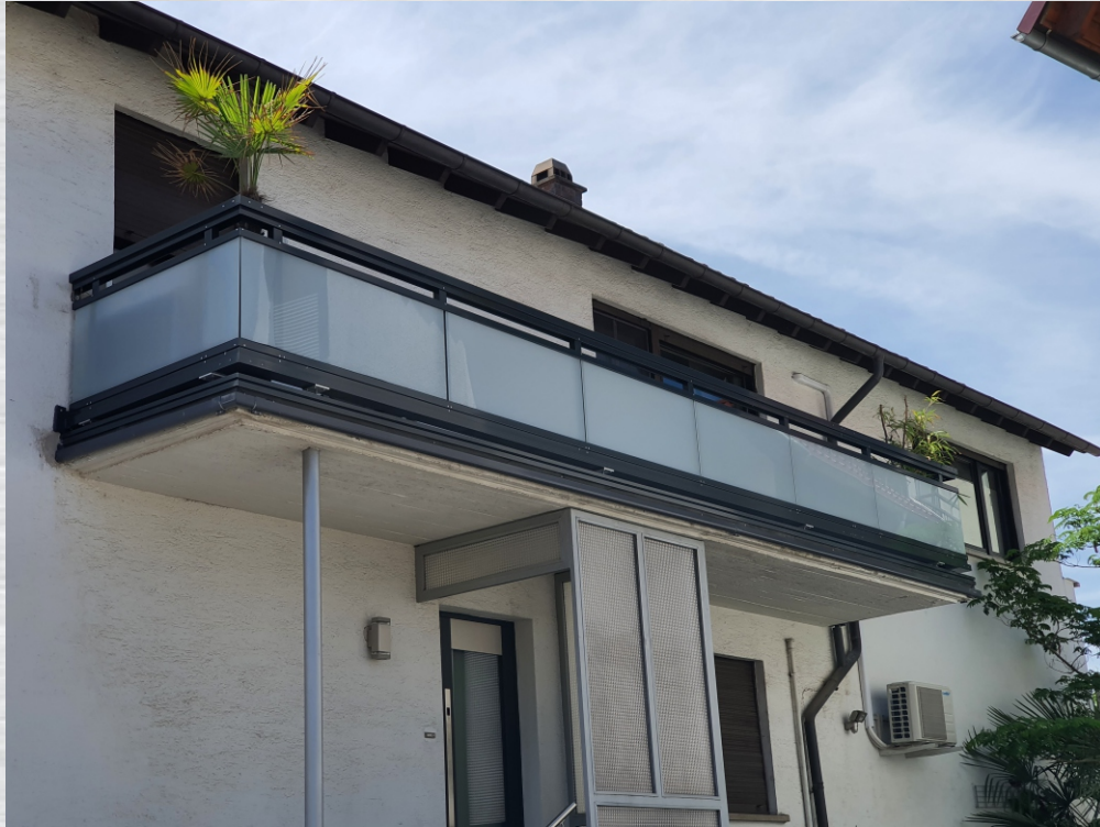
Geländer ohne Dübelbefestigung am Boden
