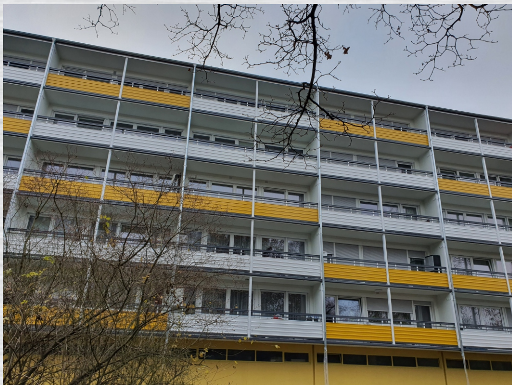
Geländer ohne Dübelbefestigung am Boden
