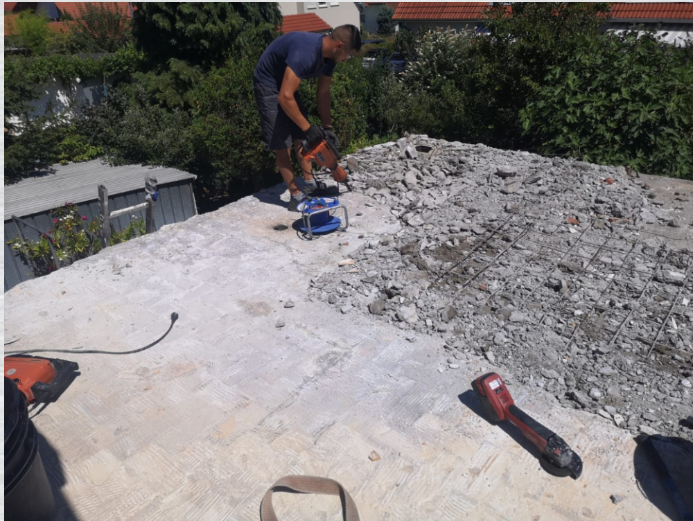
Fliesen und Estrich müssen abgetragen werden
