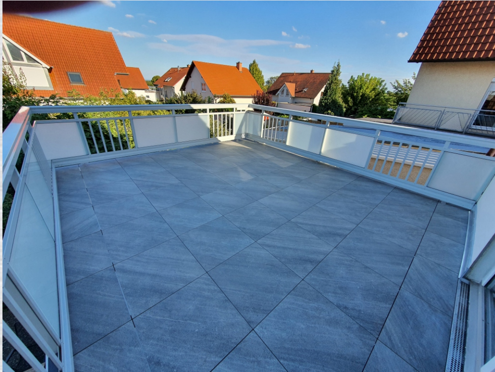
Geländer ohne Dübelbefestigung am Boden
