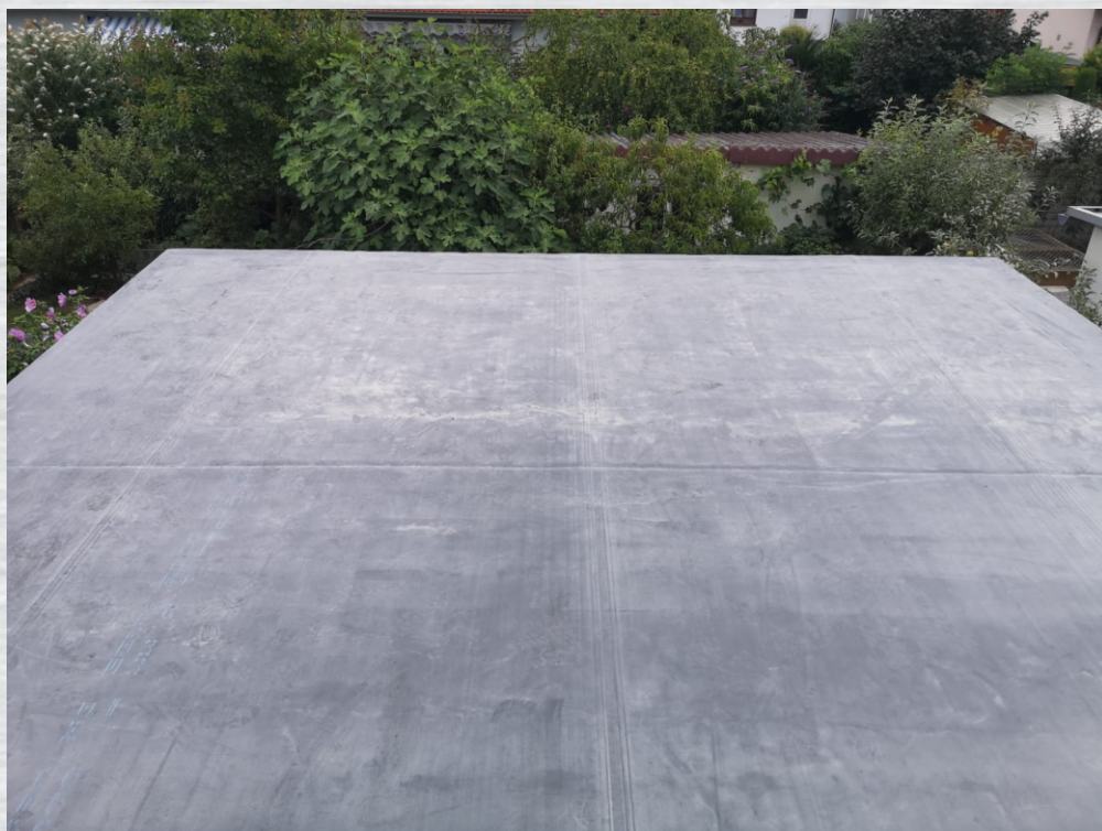
Nach dem Freilegen der Betonplatte wird diese glatt gemacht und die Dampfsperre aufgelegt.
