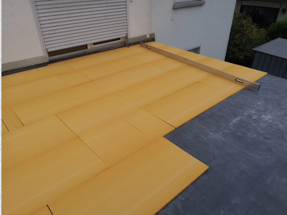
Das Gefälle wird mit Keilstyropor hergestellt
