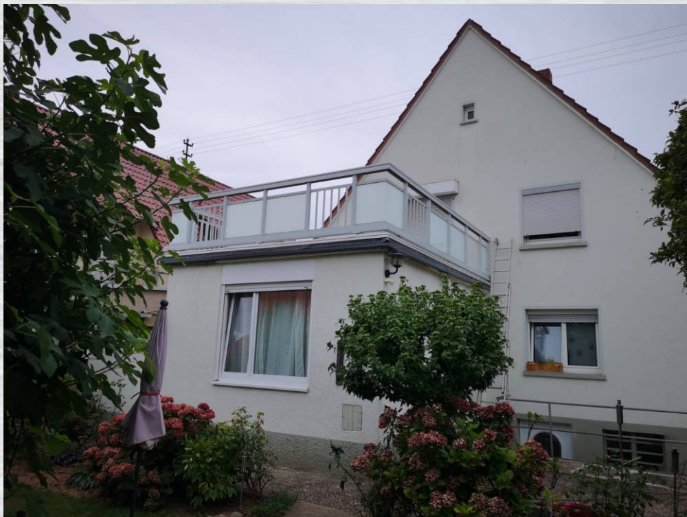
Die Ansicht von unten. Geländer mit Dübelbefestigung nach unten wäre hier ein fataler Fehler
