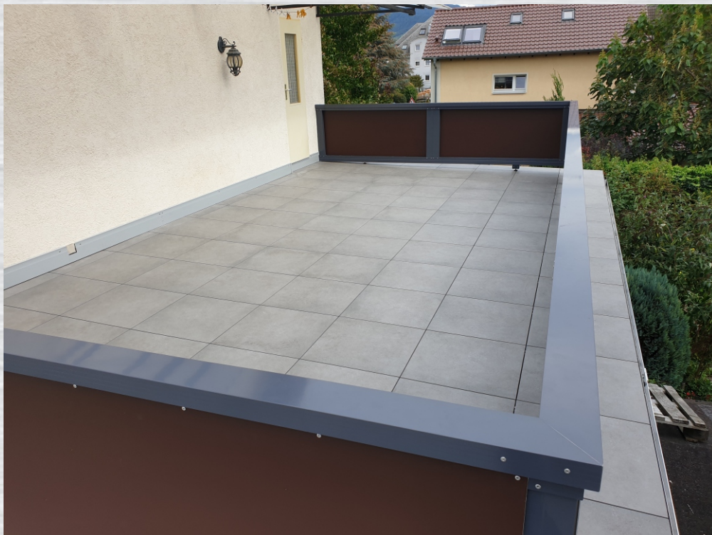
Geländer ohne Dübelbefestigung am Boden
