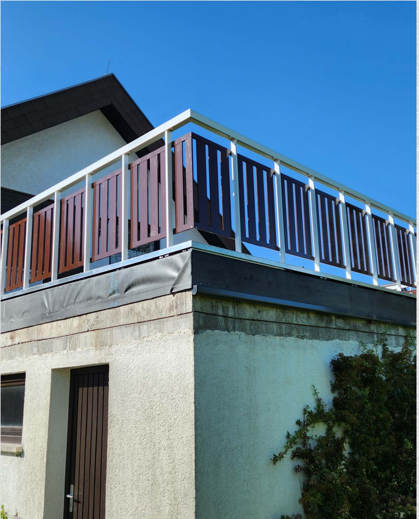
Die Ansicht von außen
